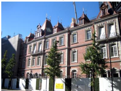
▲復元工事中の三菱一号館
