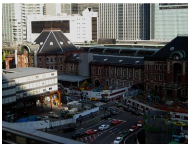
▲復元工事中の東京駅
